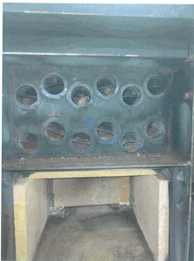
Rysunek 8 Wymiennik i zawirowywacze
