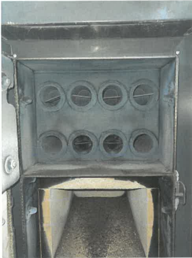
Rysunek 8 Wymiennik i zawirowywacze
