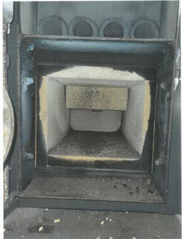
Rysunek 9 Elementy ceramiczne komory spalania
