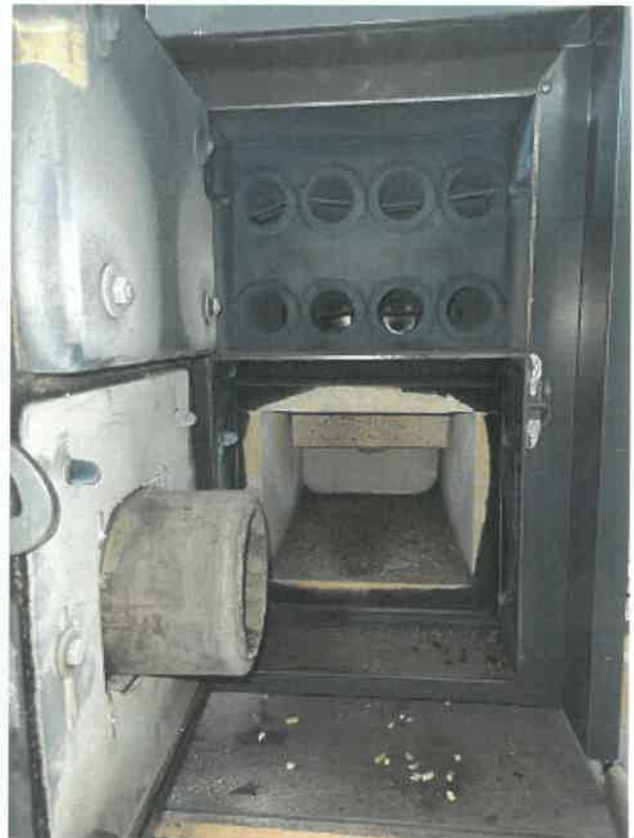
Rysunek 7 Wymiennik, komora spalania z elementami ceramicznymi, palnik pelletowy
